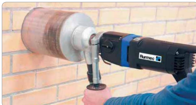
Messa in opera.
